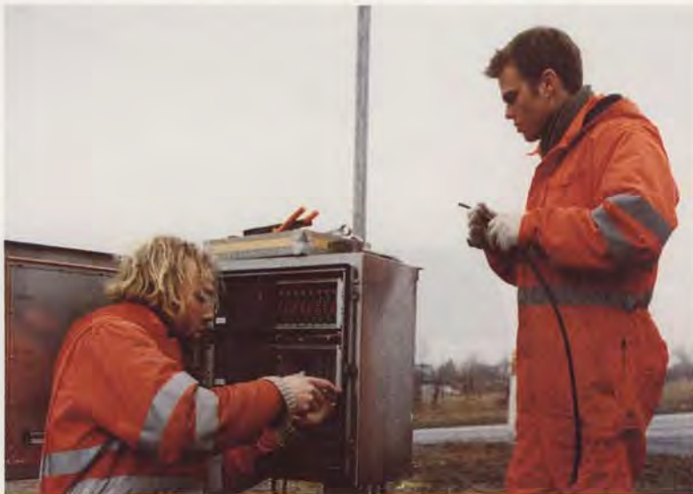
Montage af retningsantenne på detektorstation på Motorring 3 ved Gladsaxe.
