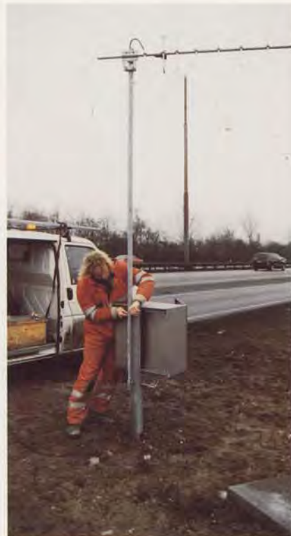
Montage af retningsantenne på detektorstation på Motorring 3 ved Gladsaxe.
