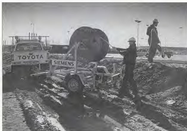
En stor del af arbejdet består i trækning af kabler, rejsning af master og montage af lamper.
