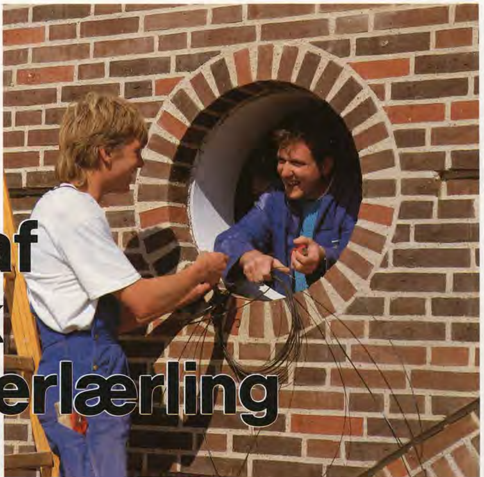
Simon (i muren) sammen med sin danske vært og kollega Jens, under installationsarbejdet på Balticas nye hovedkontor.
